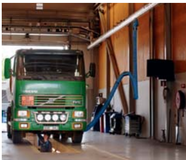
Příklad odsávacího systému pro stanice technické kontroly.
